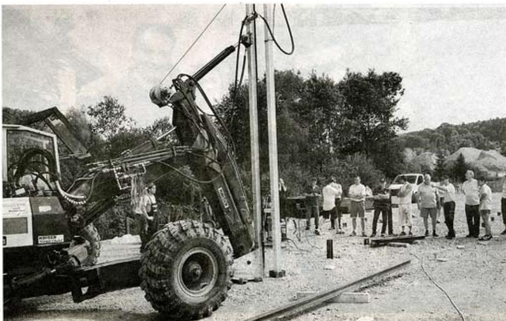
700 Pfähle werden als Fundament in den Boden gerammt.
