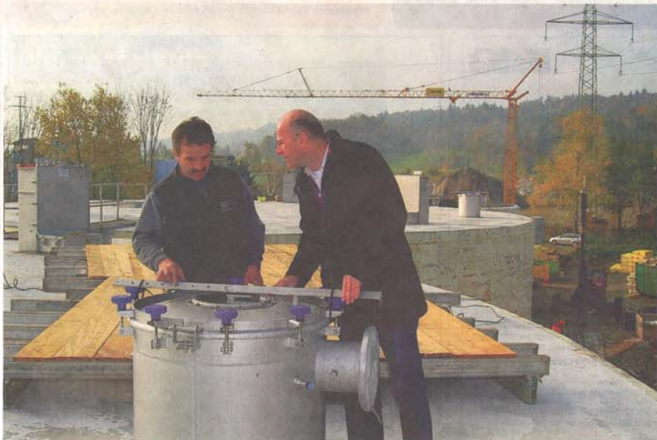
Guido Hufschmid (links) und Werner Humbel wollen die Biogasanlage in 5 Monaten in Betrieb nehmen. SL
